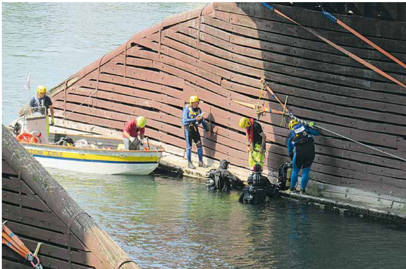
Intervento delle unità subacquee e soccorso fluviale.
